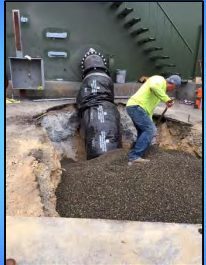
Inlet/Outlet Seismic Retrofit
