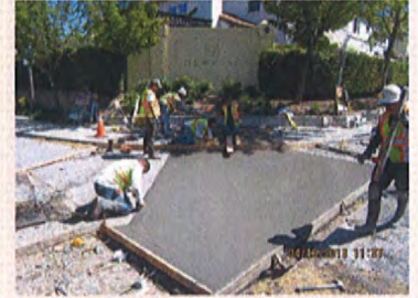
ADA Ramp on Hamilton Pkwy
