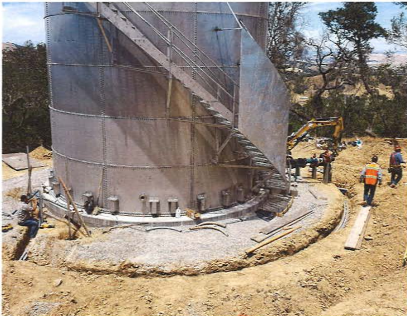
Installation of Conduits
