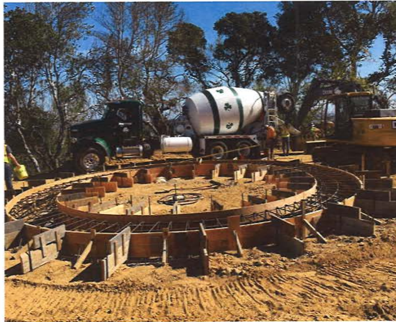
Formwork and Concrete Pour
