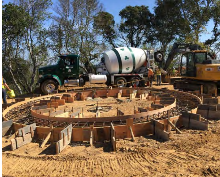
Formwork and Concrete Pour
