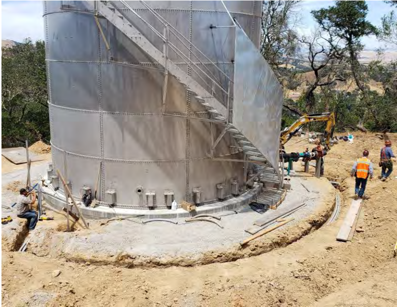
Installation of Conduits
