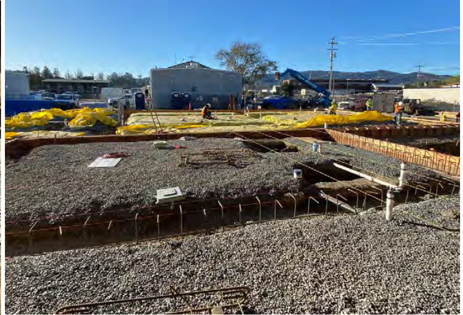
Prepping to Pour the Lab Slab
